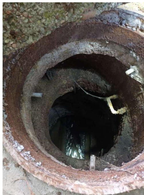
Rys. 3 Przykładowe zdjęcia studni okrągłej z pokrywą betonową między kręgami (pośrednią).
