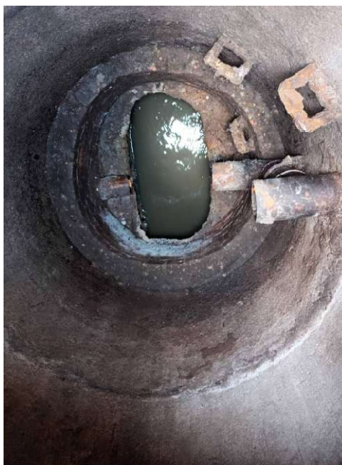
Rys. 3 Przykładowe zdjęcia studni okrągłej z pokrywą betonową między kręgami (pośrednią).
