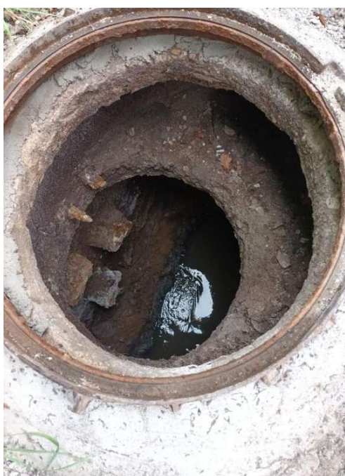
Rys. 3 Przykładowe zdjęcia studni okrągłej z pokrywą betonową między kręgami (pośrednią).
